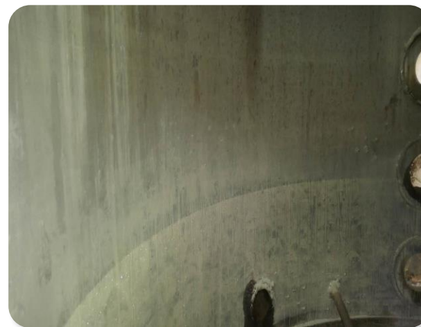
某10t/h脱硫废水蒸发罐运行3年后 内部情况（无结垢情况）
