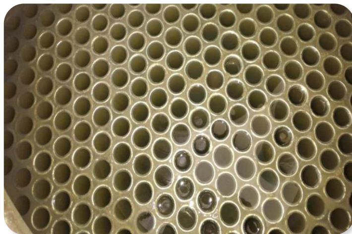
某10t/h脱硫废水加热器运行3年后 内部情况（无结垢情况）
