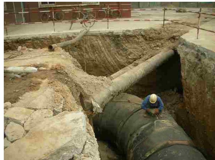
某电厂循环水管道泄漏处理场景。进行了三次挖掘，挖开了几十米长的距离才找到漏点。
