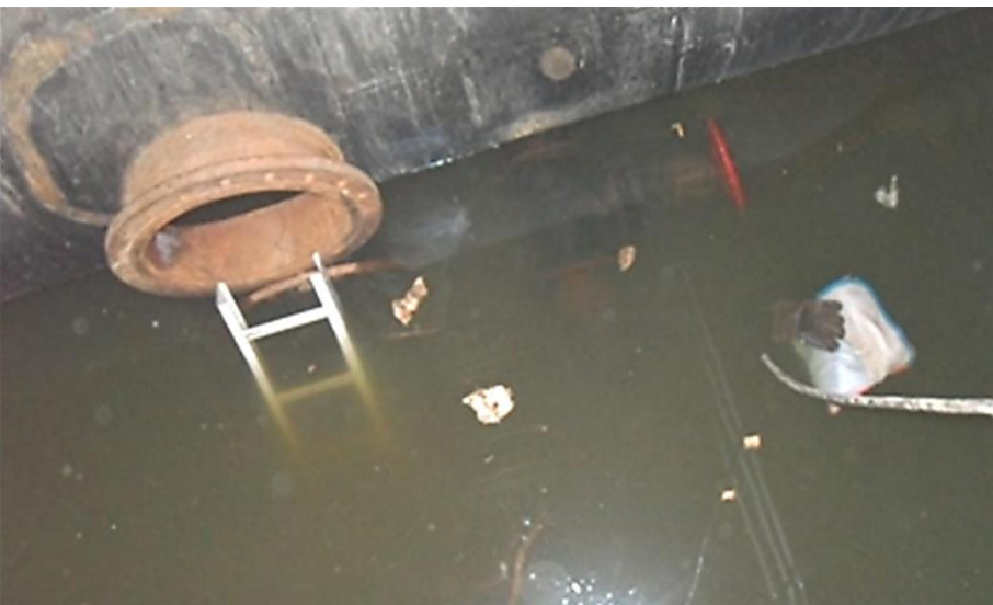
某电厂300MW机组循环水泵被淹的场景，直接导致紧急停机。
