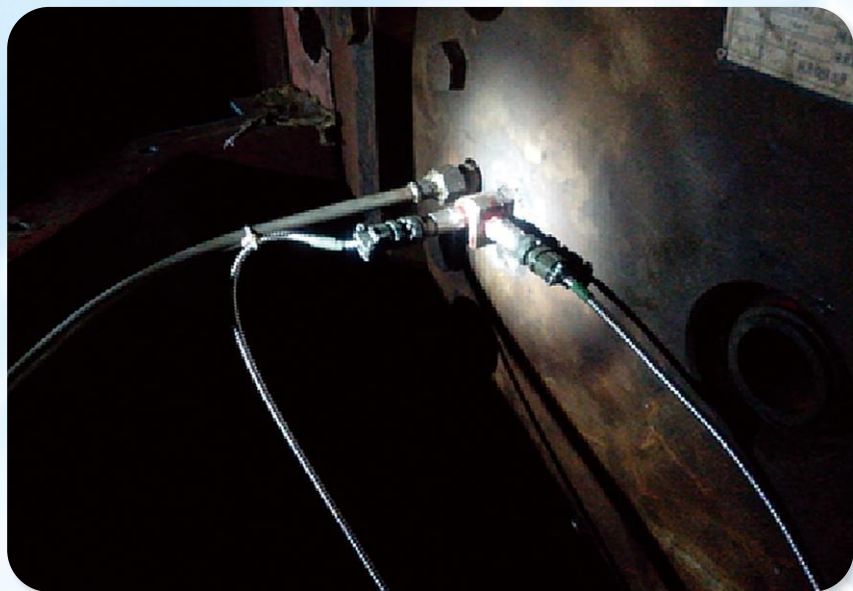
引风机轴承箱传感器安装布置图
